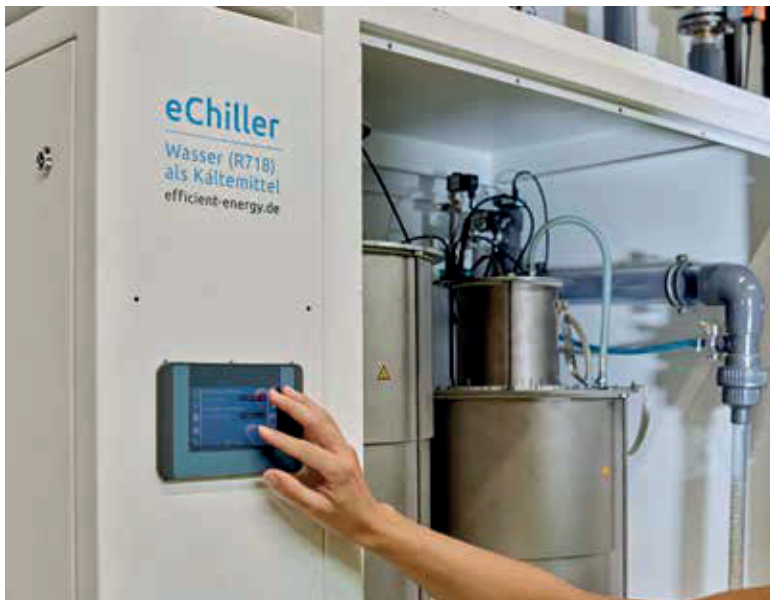
Der kürzlich von der Europäischen Kommission ausgezeichnete eChiller ist die einzige serienmäßig verfügbare Kältemaschine in einem skalierbaren Leistungsbereich von 20 bis 300 kW, die Wasser als Kältemittel nutzt.
