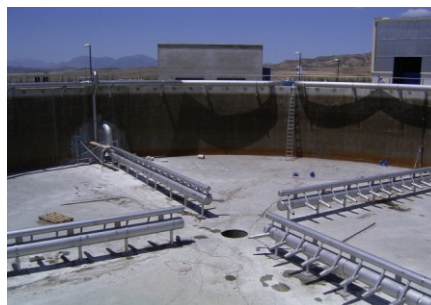
Bioreactor 5.000 m 3
